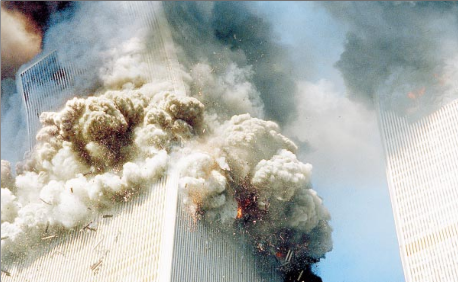
Humo, llamas y una nube de polvo. Una de las torres gemelas herida de muerte empieza a caerse a pedazos. Los emblemáticos edificios de Nueva York no lograron resistir el impacto de dos aviones y se derrumbaron. Se cree que habría miles de muertos bajo los escombros.
